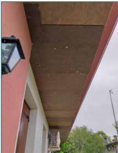
Nobilium® Thermalpanel zur Behebung von Wärmebrücken an der Außenseite
