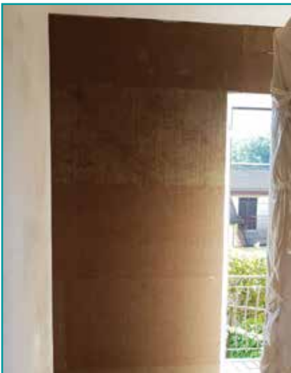
Nobilium® Thermalpanel auf Innenwand ohne Dübel mit Naturkalk verlegt.
