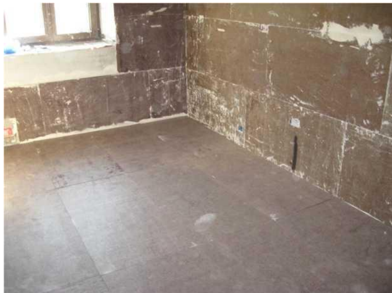
Pose sans utilisation de chevilles.
