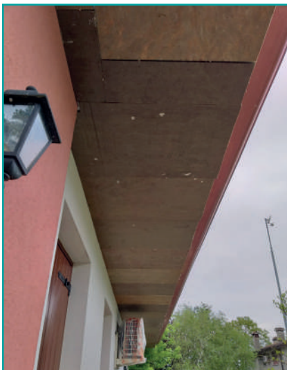
Nobilium®Thermalpanel come correzione ponte termico esterno
