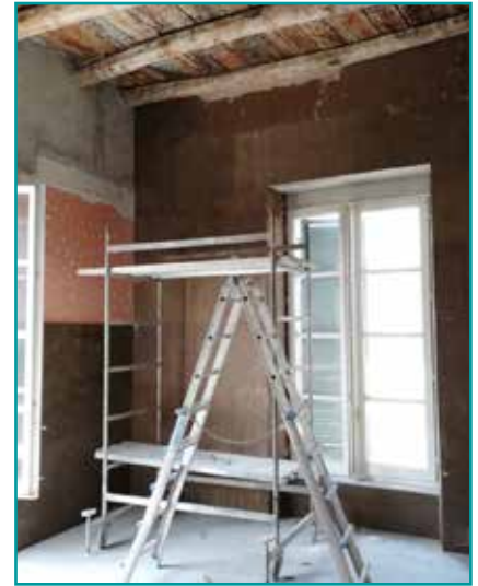
Nobilium® Thermalpanel für die Sanierung von historischen/ländlichen Gebäuden.
