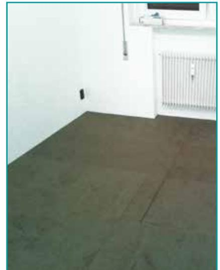
Nobilium® Thermalpanel als Trittschall- und Wärmedämmung.
